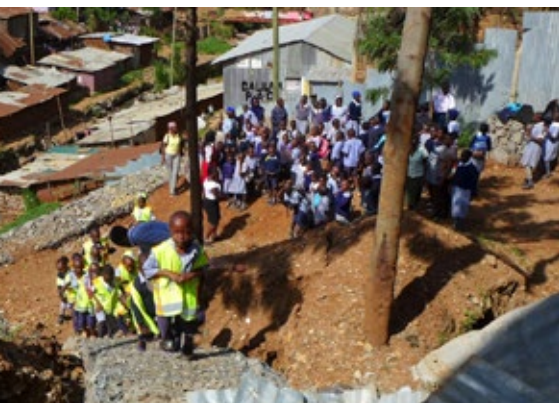
Teil der neu gewonnenen knapp 200 Quadratmeter grossen Spielplatzebene. Die Fertigstellung erfolgt, sobald es die Situation erlaubt.
