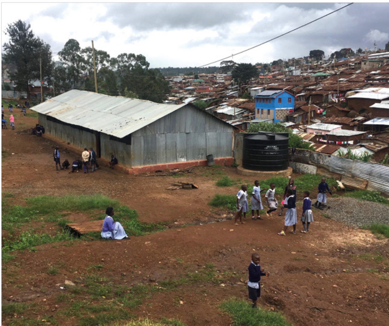
Kibera Slum - ein Schulhaus | a school house
